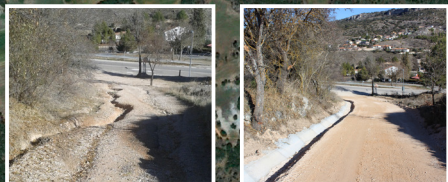
4 Camino Fuente del Quemado Antes y después de la reparación
