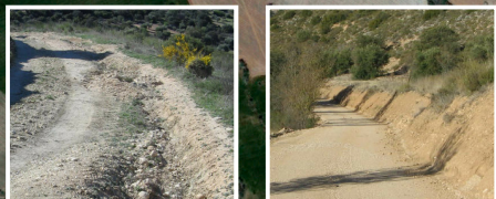
2 Camino del Llanillo Antes y después de la reparación
