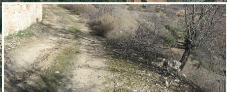
8 Camino de Orusco Estado actual
