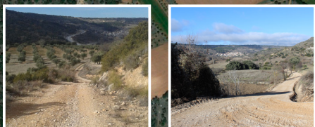
6 Camino del Moral Antes y después de la reparación
