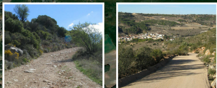
3 Camino del Cerro Grande Antes y después de la reparación
