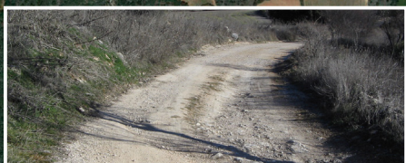
7 Finalización del Camino del Moral Estado actual
