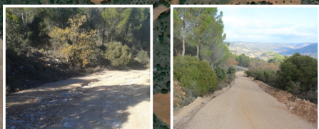
5 Camino de Zalucas Antes y después de la reparación
